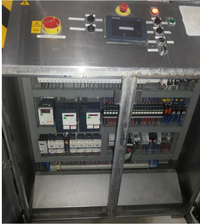
Fig.5.9. PLC kutia e kontrollit dhe rregullimit të linjës së paketimit
