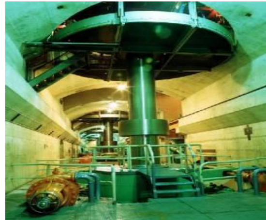
Boshti (Qafa) e cila lidh gjeneratorin dhe turbinën.
